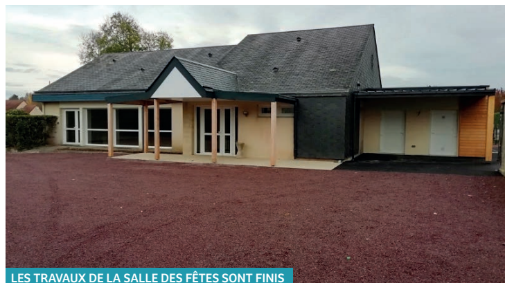
LES TRAVAUX DE LA SALLE DES FÊTES SONT FINIS
