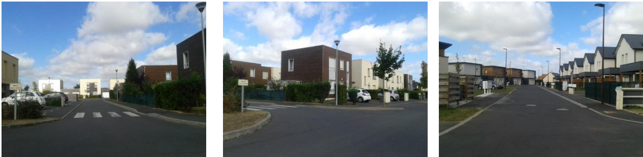
Ilot sous forme de constructions de type maisons de ville
