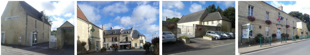
Constructions anciennes le long de la rue de Bayeux
